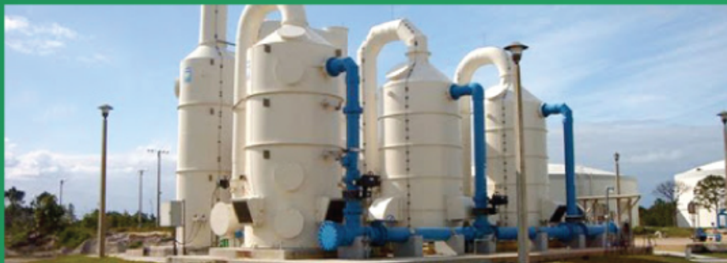
HỆ THỐNG XỬ LÝ HƠI ACID - NHÀ MÁY XỬ LÝ XI MĂNG YUJIN VINA
